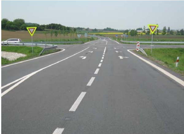
Obr. 6 – Křižovatka silnic I/47 a II/367 po modernizaci
