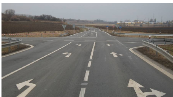
Obr. 3 – Komfortní uspořádání vedlejší silnice nepodporuje povinnost dát přednost v jízdě
