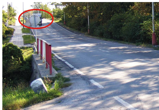
Obr. 14 – Svislé dopravní značení omezuje rozhled z vedlejší silnice
