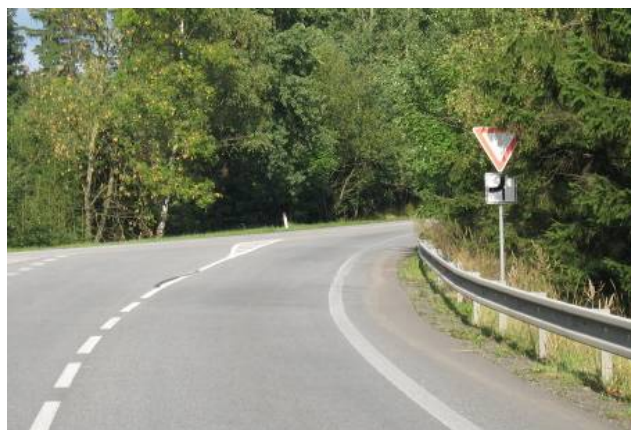
Obr. 9 – Tato dopravní značka je nejen málo výrazná, ale navíc zakryta rostoucí zelení
